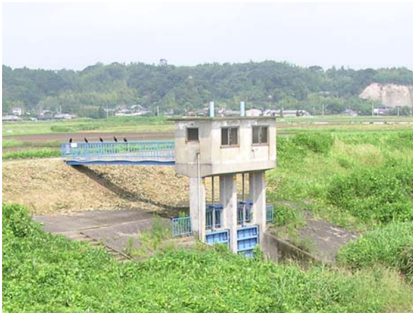
写真 2.1.10 樋管 (中郷第3 樋管：支川串良川)
