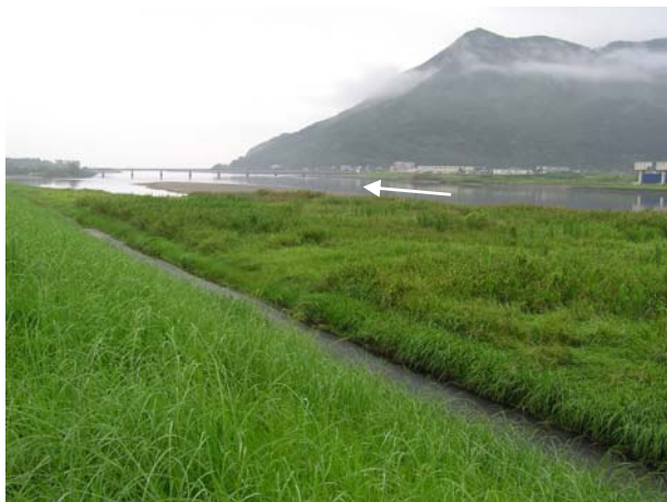
写真 2.2.16 高水敷草地 (肝属川本川左岸 2k000 付近)
