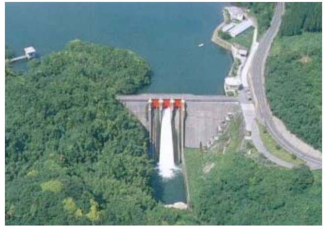
写真 1.3.2 高隈ダム（支川串良川）
