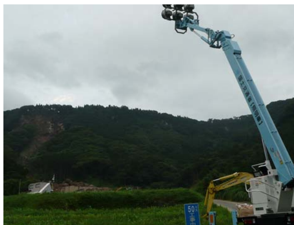
写真 4.3.18 夜間監視用の照明車
