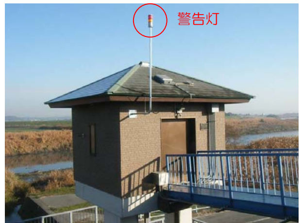
写真 4.3.13 樋管の警告灯
