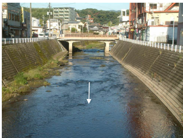
写真 2.2.7 鹿屋市街地中心部 (肝属川本川 18k400 付近)
