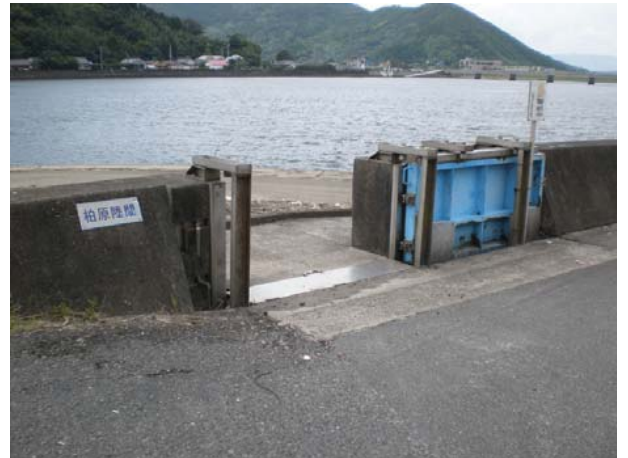
写真 2.1.11 陸閘門 (柏原陸閘：肝属川本川)
