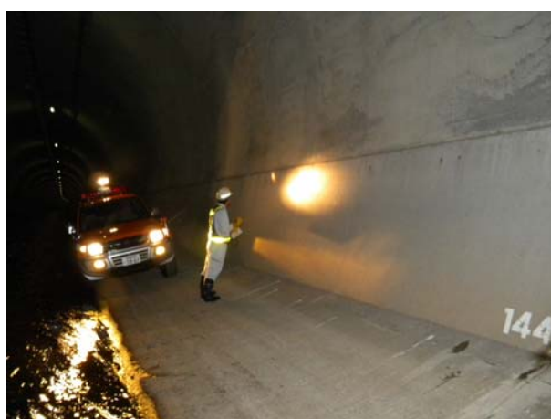
写真 4.3.9 鹿屋分水路の点検
