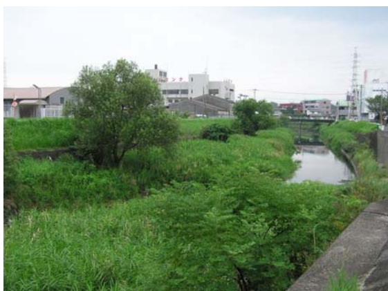
写真 4.3.1 河道内堆積土砂及び樹木 (肝属川本川：川西地区付近)
