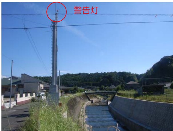
写真 4.3.12 川の警告灯（支川下谷川）
