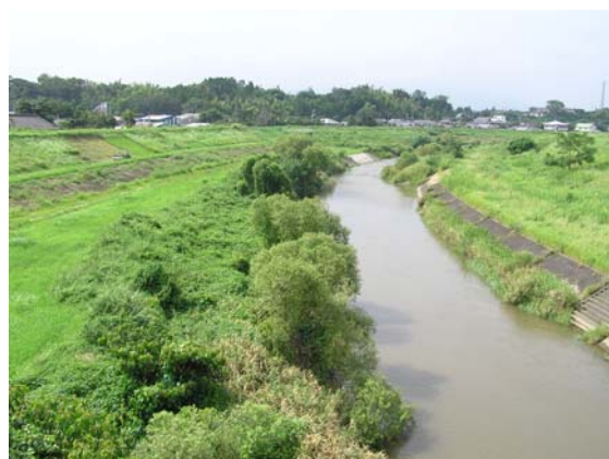
写真 4.3.2 河道内に繁茂しつつある樹木 (支川高山川：前田地区付近)
