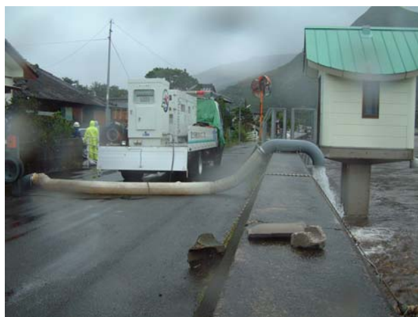
写真 2.1.3 排水ポンプ車による内水排除
